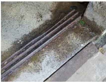
Fig. 04 – Visualização parcial do trilho a ser substituído.
