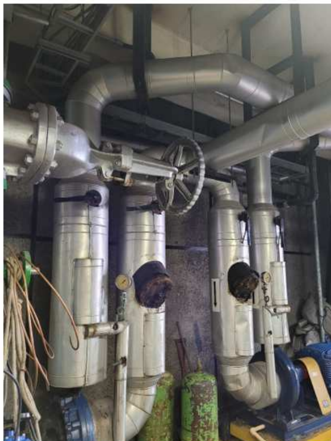
Fig. 03 – Delimitação da área para substituição do isolamento térmico e proteção mecânica – tubos de sucção e recalque de água gelada deverão ser isolados (abaixo das válvulas borboletas, as mesmas inclusive).
