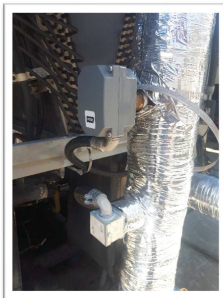
Fig. 3 – Transmissores a serem relocados em ambos os chillers
