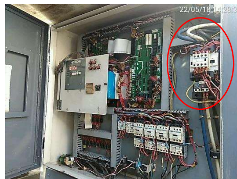
Foto 08: Problemas com o contator de potência.
