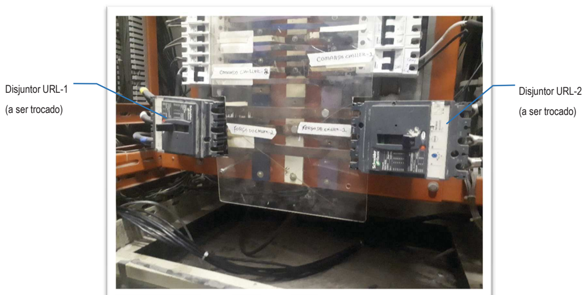
Fig. 5 – QECAG| Substituição dos disjuntores das URL-1 e 2
