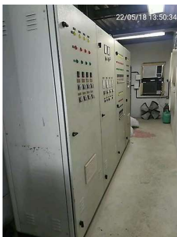
Foto 1: QE-01 Quadro de alimentação dos chillers
