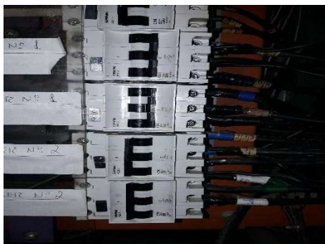
Foto 03: Disjuntores dos chillers.
