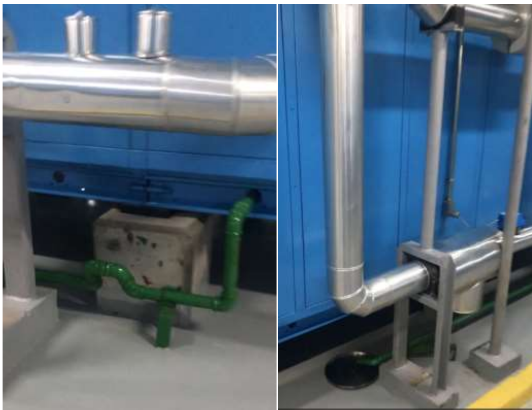
Figura 3 - Detalhe de drenagem das UTAs
