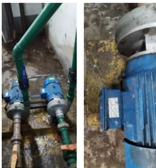
Figura 5 - Sistema de bomba de abastecimento da cisterna.
