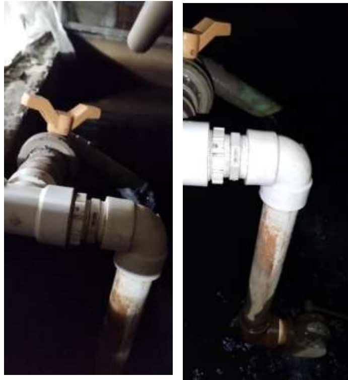
Figura 7 - Tubulação de abastecimento e boia da Cisterna no térreo
